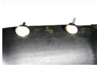
9.f. Wacht tot het PUR schuim volledig is uitgereageerd (ca. 2 uur). Sla de twee ventilatiepluggen tot aan de kraag in de mof, zodat de onluchtingsgaten in de mof vallen. Controleer of er geen schuim / lucht langs de manchetten is ontweken. Indien toch schuim is ontweken is de mof lek en dient dit geheel te worden verwijderd.
