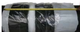
7.b. Meet de lengte van de mof.
