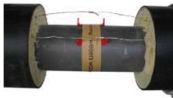
5.d. Verbindt de draadjes met een soldeerbusje en trek de draden strak.
