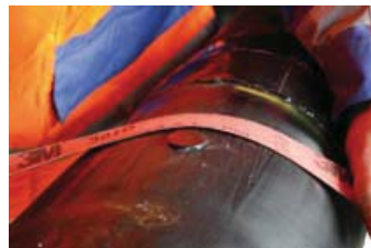
9.i. Ruw de PE krimpmof rondom de ventilatiepluggen op met schuurlinen.
