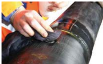
9.j. Maak deze met een alcohol vet, vuil en watervrij.
