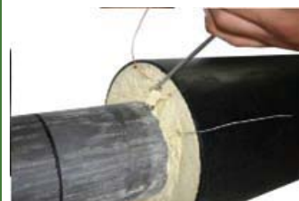
6.b. Eventueel nat (verzopen) PUR schuim dient zorgvuldig worden uitgestoken totdat droog schuim wordt bereikt. Voorzichtig nabij de lekbewakingsdraadjes deze mogen niet worden beschadigd.
