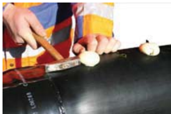
9.g. Verwijder de schuimresten rond de ventilatiepluggen zorgvuldig.
