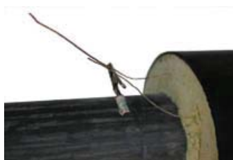
1.b. Verbindt de lekbewakings-draadjes aan de andere zijde van de buis door d.m.v. een klemmetje of kroonsteentje.
