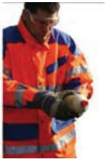
9.d. Sla in één van de twee geboorde gaten de ventilatieplug erin
