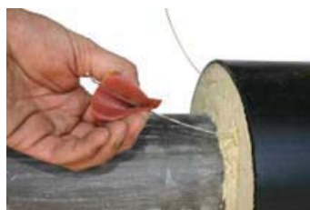
1.a. Schuur de lekbewakingsdraadjes op met schuurpapier.
