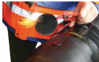
9.l. Verwarm beide fobs met een zachte vele vlam totdat de doffe plaklaag gaat glanzen.
