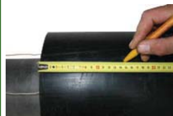
7.c. Neem de lengte van de mof. Haal hiervan de lengte van het ongeïsoleerde leidingstuk vanaf. Deel dit door twee. Markeer de voorgeïsoleerde leidingen over de berekende afstand, gemeten vanaf de PE leidingeinden. Tussen deze markering dient later de mof te worden aangebracht.
