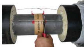
5.e. Met een quetschtang het busje samenspersen.
