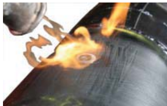
9.k. Daarna voorzichtig voorverwarmen met zachte gele vlam, zodat het vocht kan verdampen. Voor het aanbrengen van de fob dient de PE mantel en de mof een temperatuur te hebben van circa 60°C.
