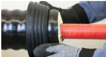
8. Mauerdichtring montieren.
