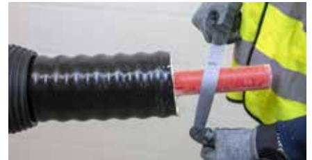
6. Entfernen Sie den verbleibenden Schaum mit Hilfe von Schleifpapier.
