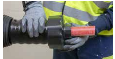
9. Schrumpfendkappe gemäss beiliegender Montageanleitung montieren.
